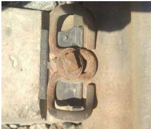
Рис. 3 – Установка скріплення VOSSLOH SYSTEM W-30 в колії
