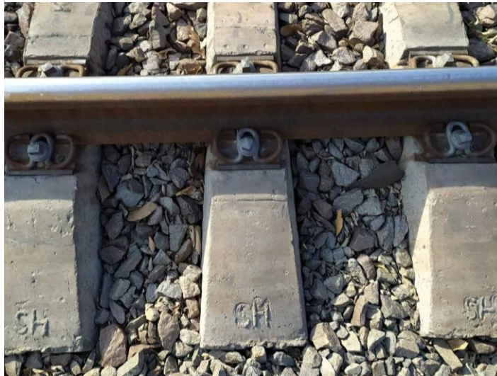
Рис.5 – Установка скріплення SBS W SL-1-900-R65 в колії
